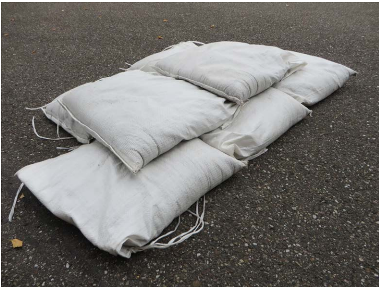
Abb. 10b: Beginn eines Sandsackdammes
