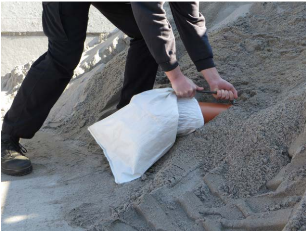
Abb. 3a: Füllen mit einer Person
