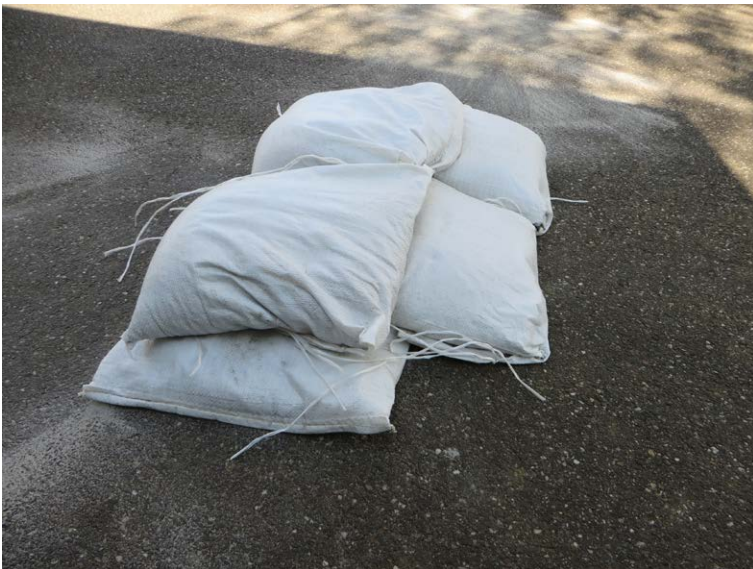
Abb. 11b: Beginn eines Sandsacknotdammes
