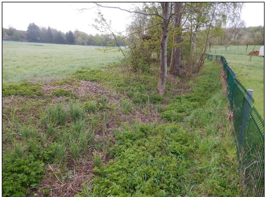
Foto 1: In Verlängerung des Bauerbachs befindet sich dieser von Gehöl- zen bestandene Graben. Er scheint nicht regel- mäßig Wasser zu füh- ren.
